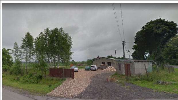
Istniejąca zabudowa od strony skrzyżowania drogi powiatowej (ul. Gminnej) i drogi gminnej prowadzącej do miejscowości Kuchary.
