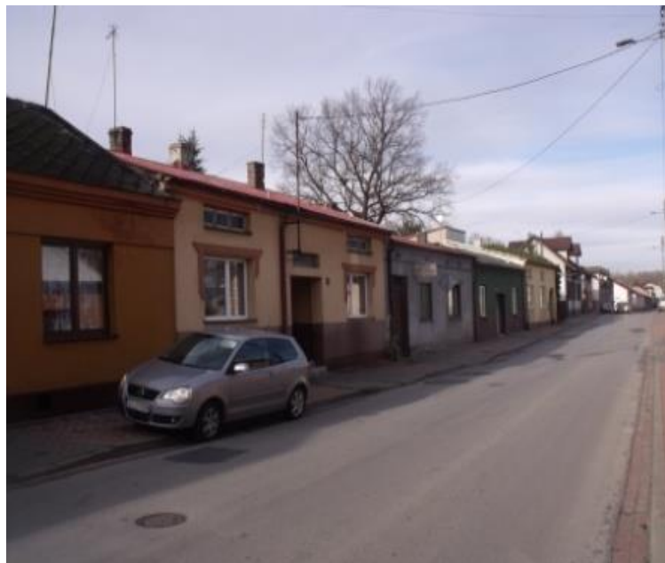
Mstów , zmodernizowane domy przy ul.Wolności
